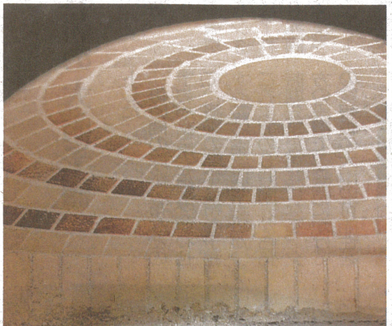
増田煉瓦が製造したピザ窯のドーム内部。レンガが整然と並び、本場のイタリア人も驚いたという
